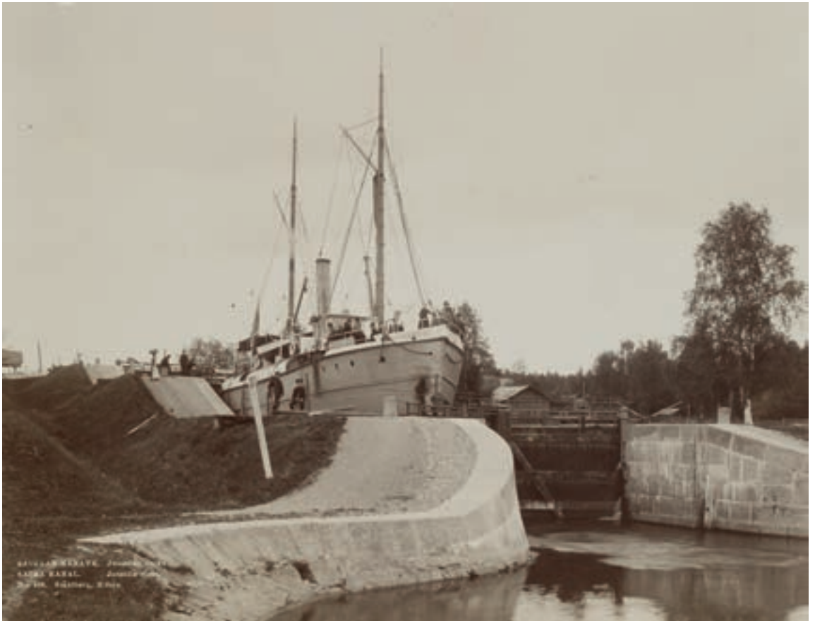
■ Saimaan kanava oli aikansa (1844–1856) merkittävin rakennushanke Suomessa. Kanavan valmistuminen vähensi Suomen talouden riippuvuutta Ruotsista ja toi rahatalouden suureen osaan Itä-Suomea. Kuva 1900-luvun alkuvuosilta.
